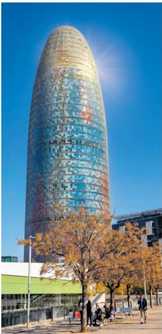
Centro de soporte de Oracle en Torre Glòries (Barcelona). GETTY
